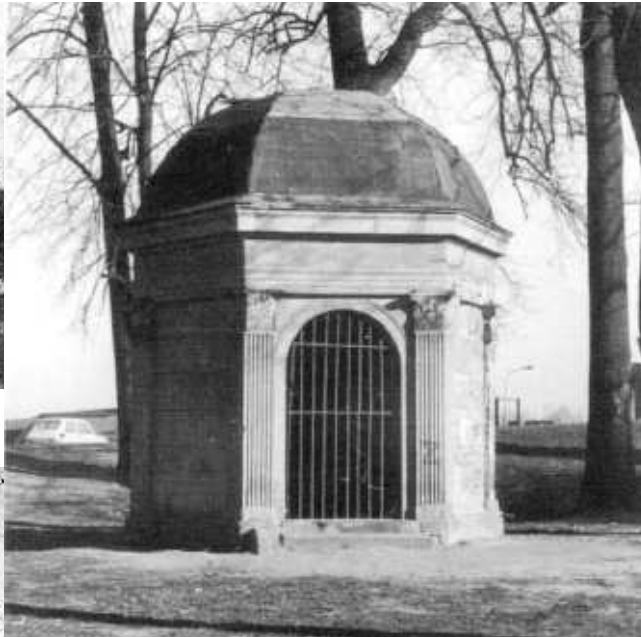
Tzw. kapliczka na Osiedlu Pomorskim. Za: Barbara Bieliniś-Kopeć Zabytki Zielonej Góry, 2005
