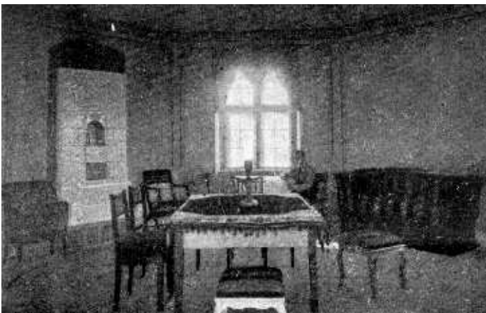
Wnętrze Wielkiego Nabota
